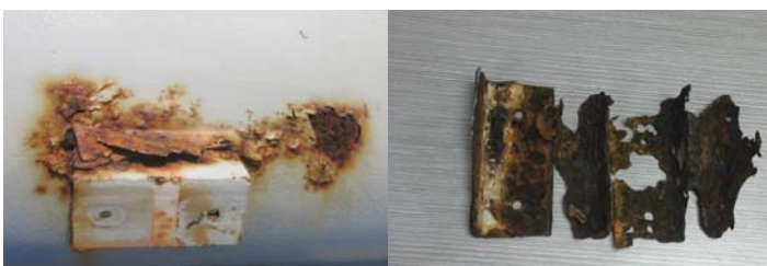
Hình 5. Ăn mòn mạnh tại vị trí mối hàn giữa thân ống và "tai" đỡ mái che trên tuyến ống
